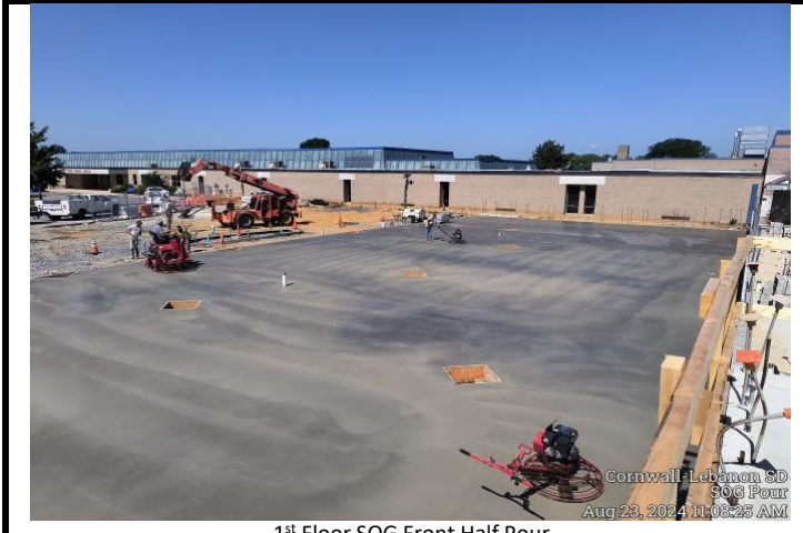
1st Floor SOG Front Half Pour
