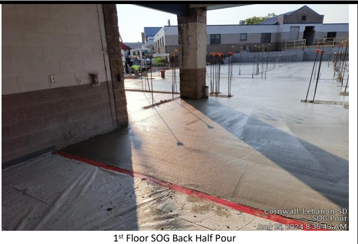
1st Floor SOG Back Half Pour
